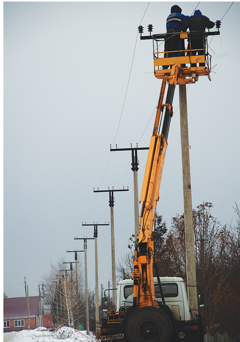
За два года в ремонт электрических сетей вложено 200 млн руб.
