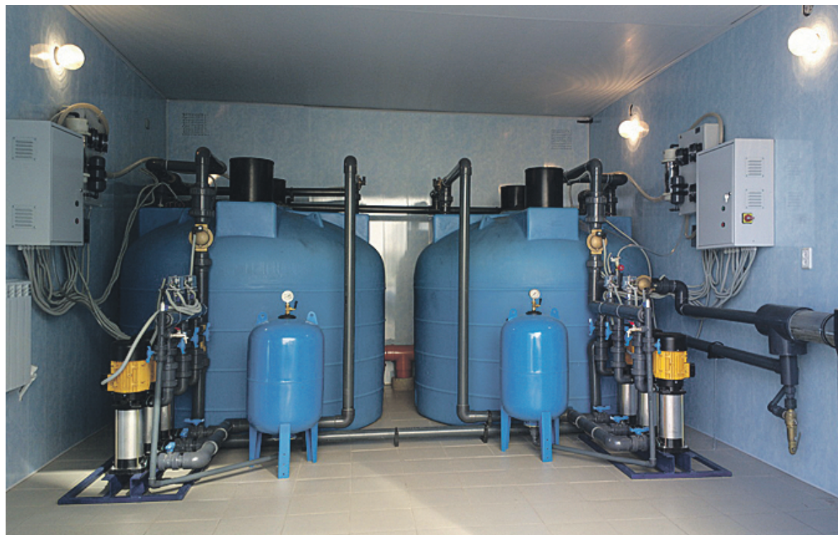
Новая станция доочистки воды в Котовске появилась уже в этом году.
