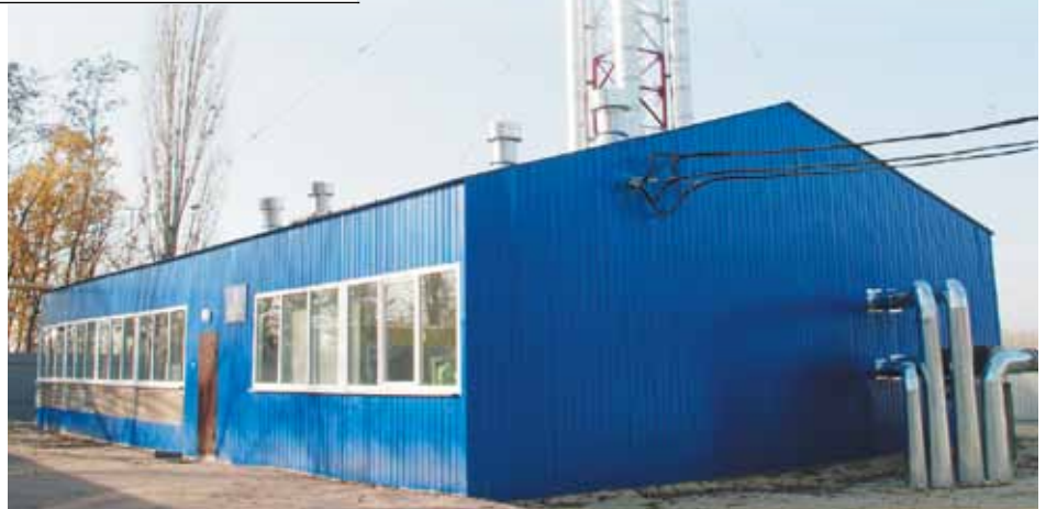
Котельная в г. Уварово.
