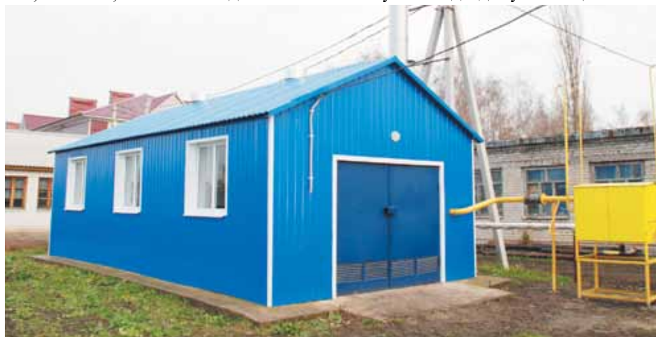
Котельная в р. п. Токаревка.
