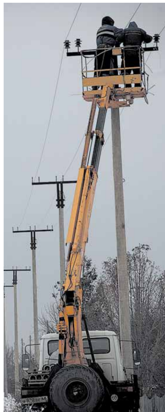
Строительство и реконструкция электросетей в г. Уварово.
