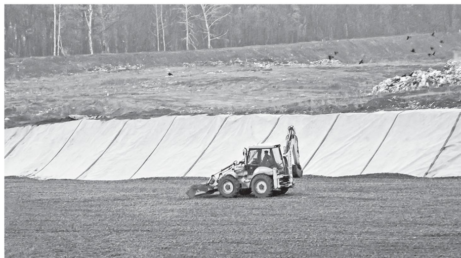
Строительство полигона. Осень 2018 года
