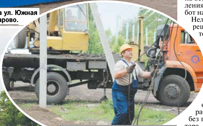
Идет строительство котельной в 1-ом микрорайоне г. Уварово.
