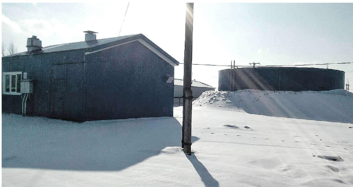
Закончено строительство станции второго подъёма.
