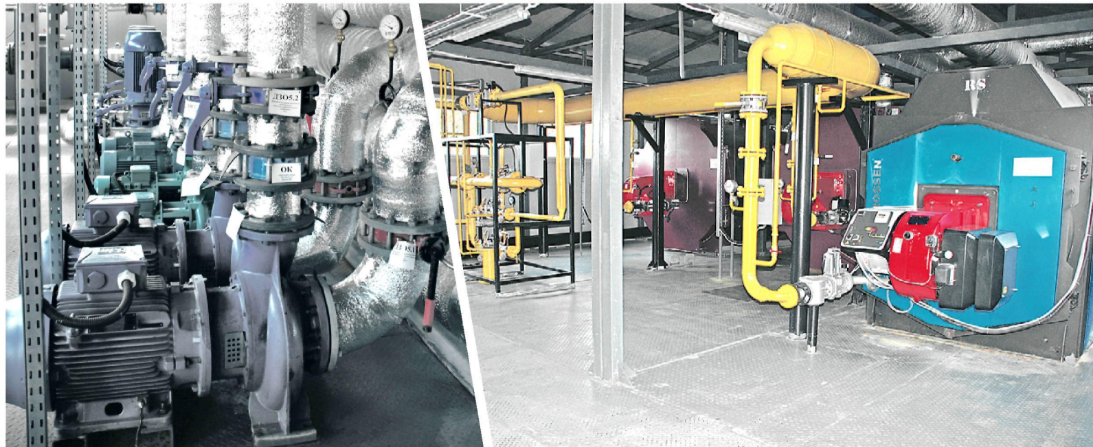
Две новых котельных в Мичуринске успешно показали свою работу.
