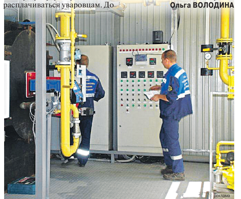
В котельной г. Уварово все готово к пуску.
