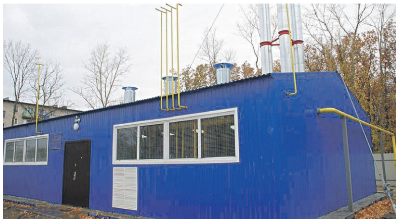
Новая котельная в микрорайоне Молодёжный г. Уварово.
