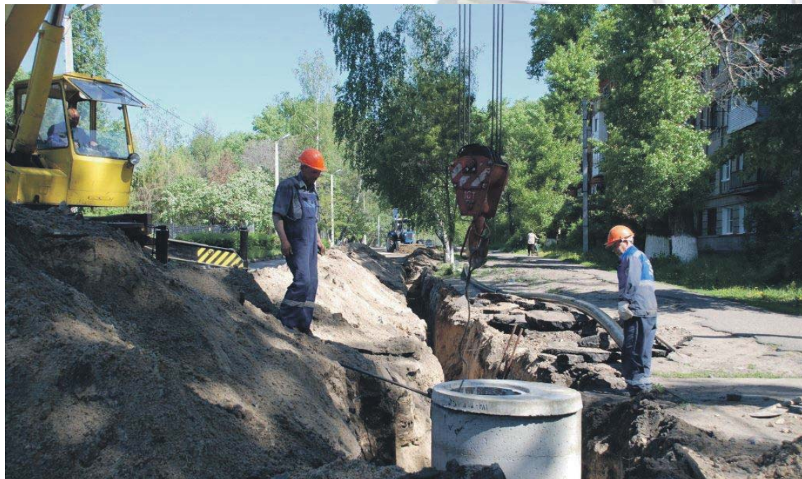
Идет прокладка водопроводной линии.
