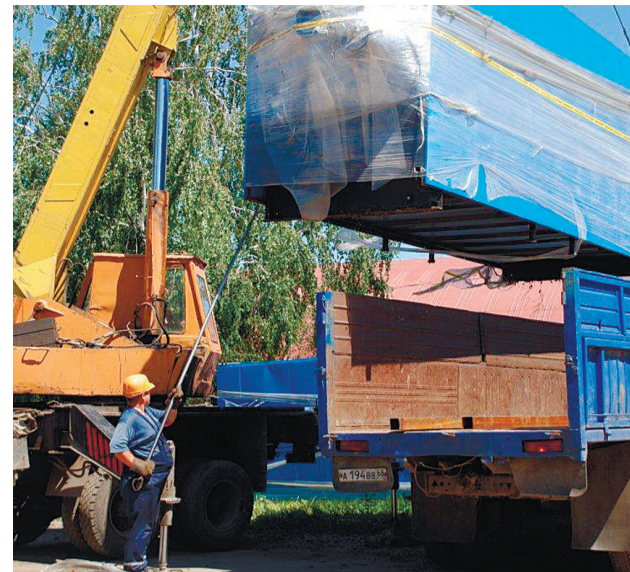
Погрузка нового оборудования для котельной 2-го микрорайона г. Уварова.
